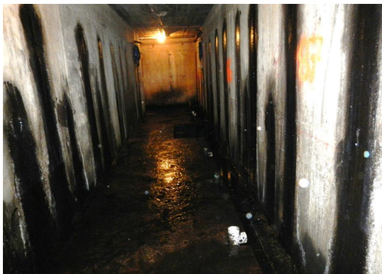
Fotografía 6.9 Galería de margen Izquierda
