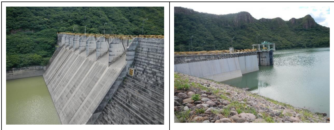
Fotografía 6.2 Vista desde aguas abajo de la presa principal
