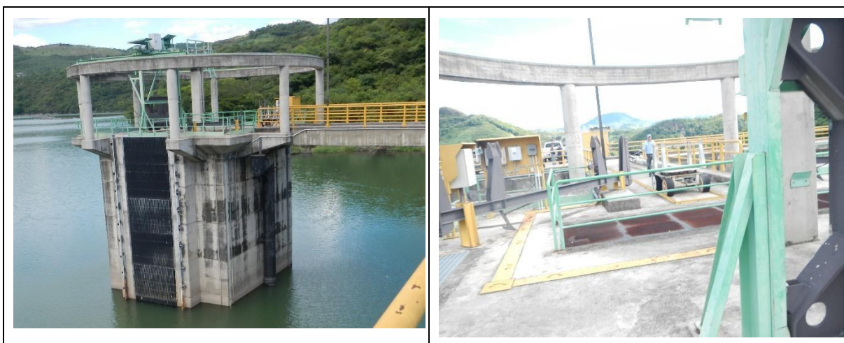
Fotografía 6.10 Obra de Toma
