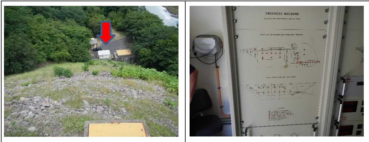
Fotografía 6.3 Casilla de Auscultación y sistema automático de medición de instrumentos
