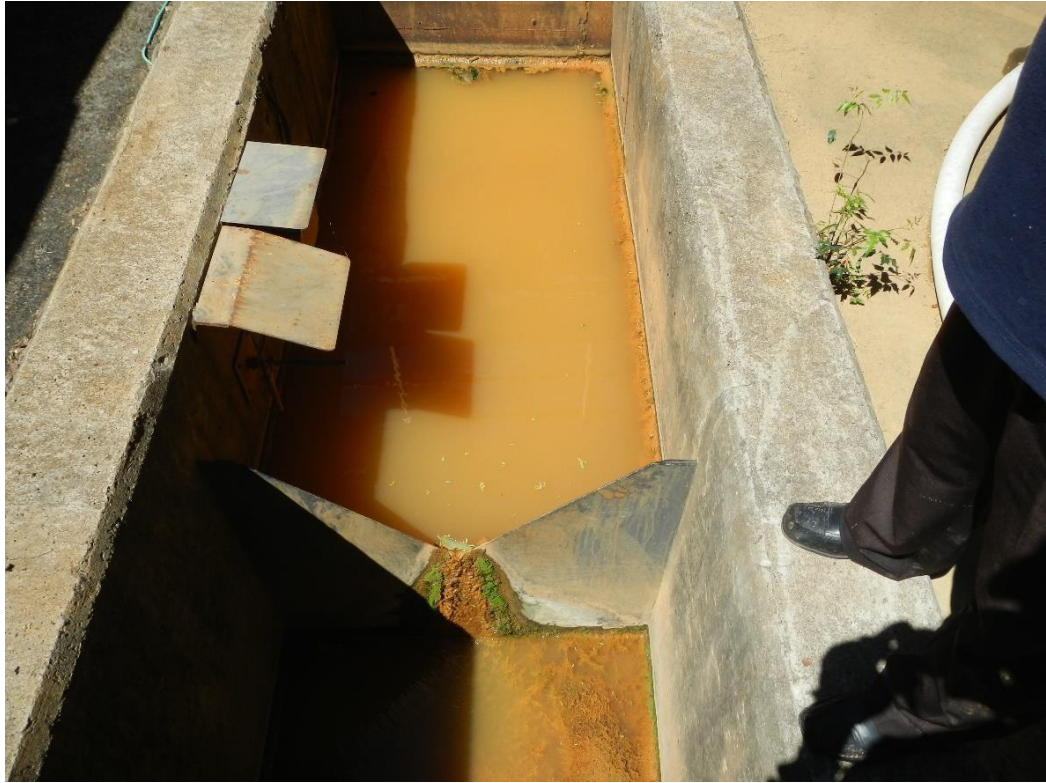
Fotografía 6.5 Sistema de aforo totalizador presa de hormigón
