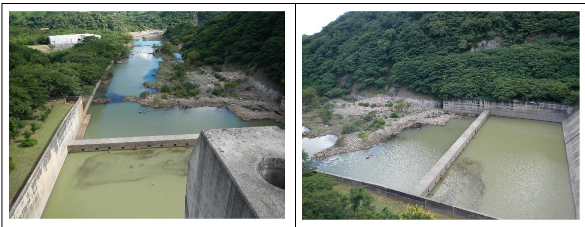
Fotografía 6.14 Vertedero, canal de descarga
